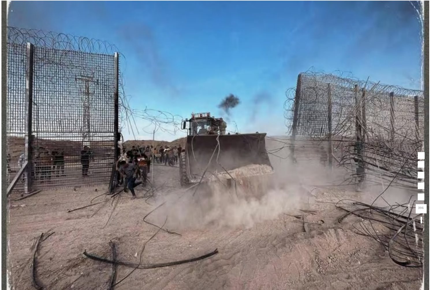
הגדר שפרצה בדרום רצועת עזה
